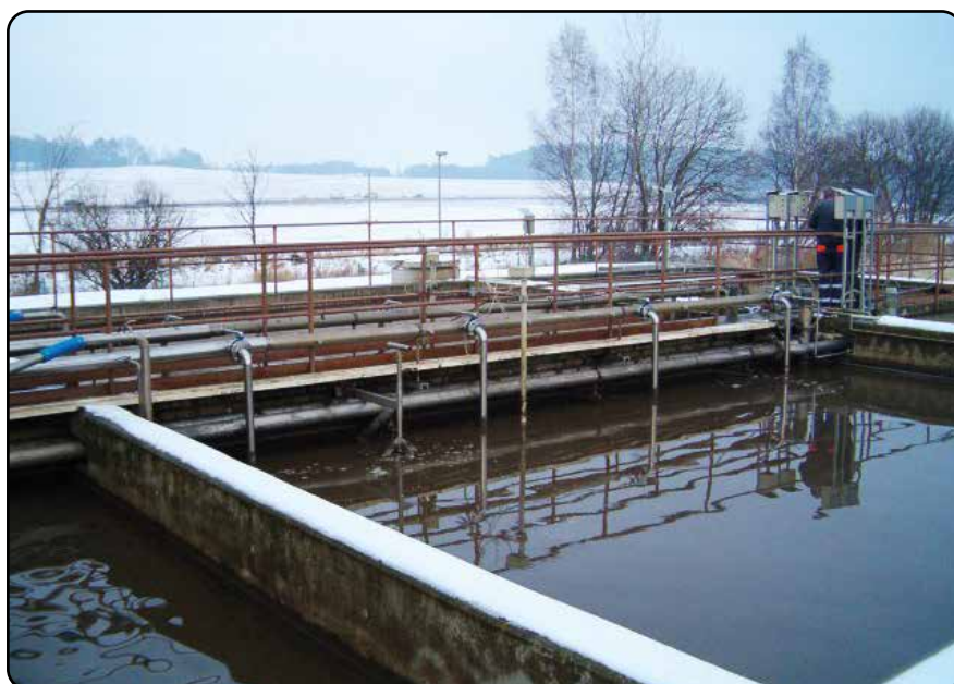
Čistírna odpadních vod již kapacitně nestačí, byly zahájeny práce na jejím rozšíření
